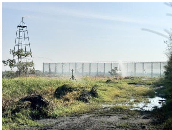
รูปที่ 15 การฉีดพรมน้ำ บริเวณกองเถ้า
